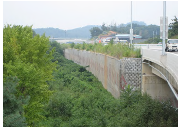
1공구 보강토옹벽(지선 STA.0+321~0.680)
