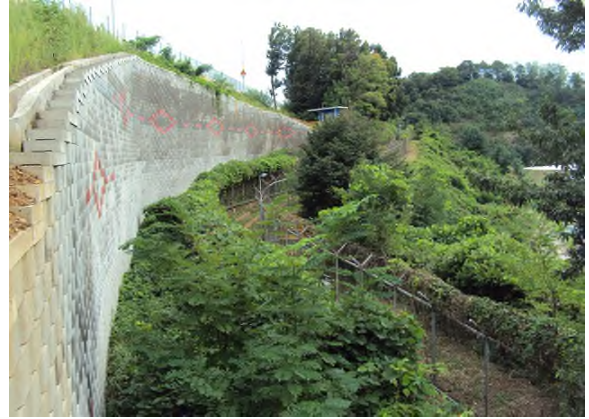
1공구 보강토옹벽(본선 STA.1+914~2+020)
