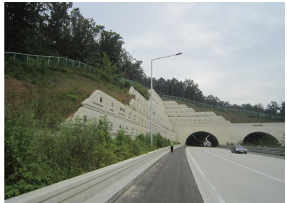
1공구 보강토옹벽(본선 STA.6+933~7+040)
