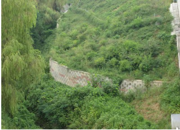
1공구 보강토옹벽(본선 STA.0+283~0+400)
