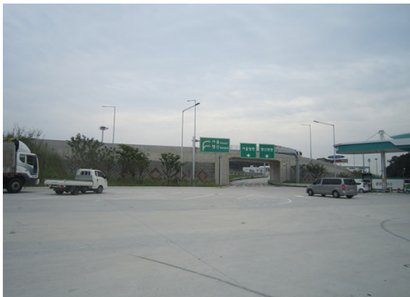
1공구 보강토옹벽(본선 휴게소통과교량)
