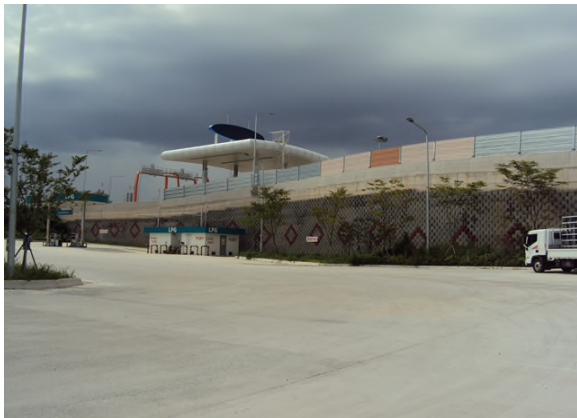
1공구 보강토옹벽(본선 STA.4+993~5+110)
